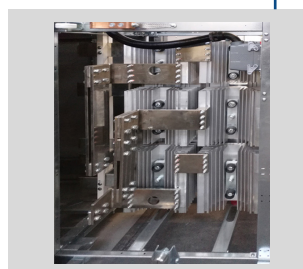
Diode Graetz bridge Ponte di Graetz a diodi
