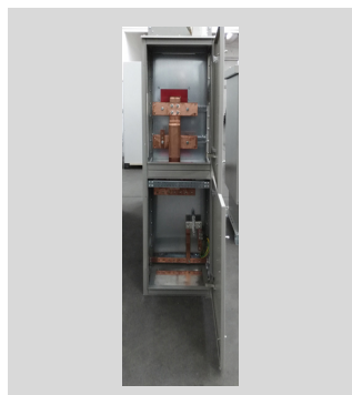
Omnibus busbar Sbarre Omnibus
