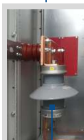
Surge Arrester Scaricatore (OPTIONAL)
